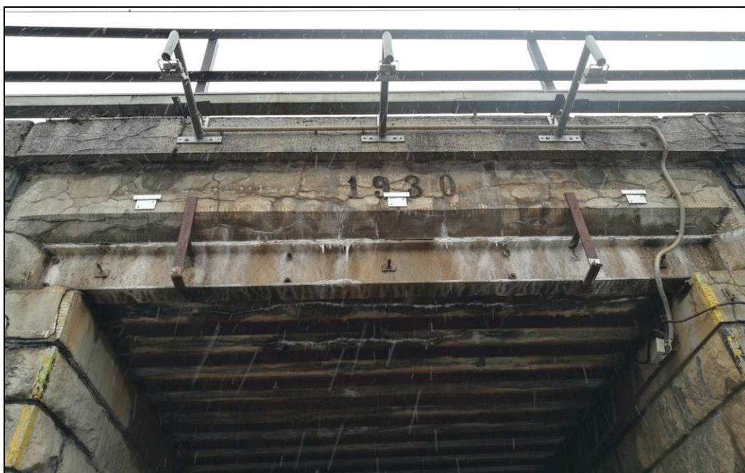
Obr. č. 7 - pohled na vlasové trhliny v čele NK a betonové římsy
