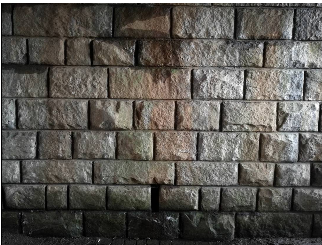
Obr. č. 5 - pohled na kamenné zdivo opěry - v patě s odvodňovacím otvorem
