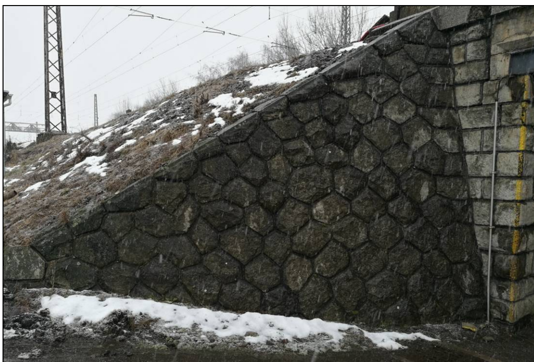
Obr. č. 8 - pohled na šikmé křídlo - v líci tvořené kyklopským zdivem, bez poruch
