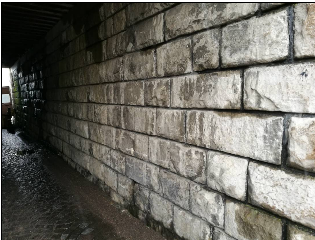
Obr. č. 4 - pohled na opěru Zábřeh n. M. - v líci řádkové kamenné zdivo
