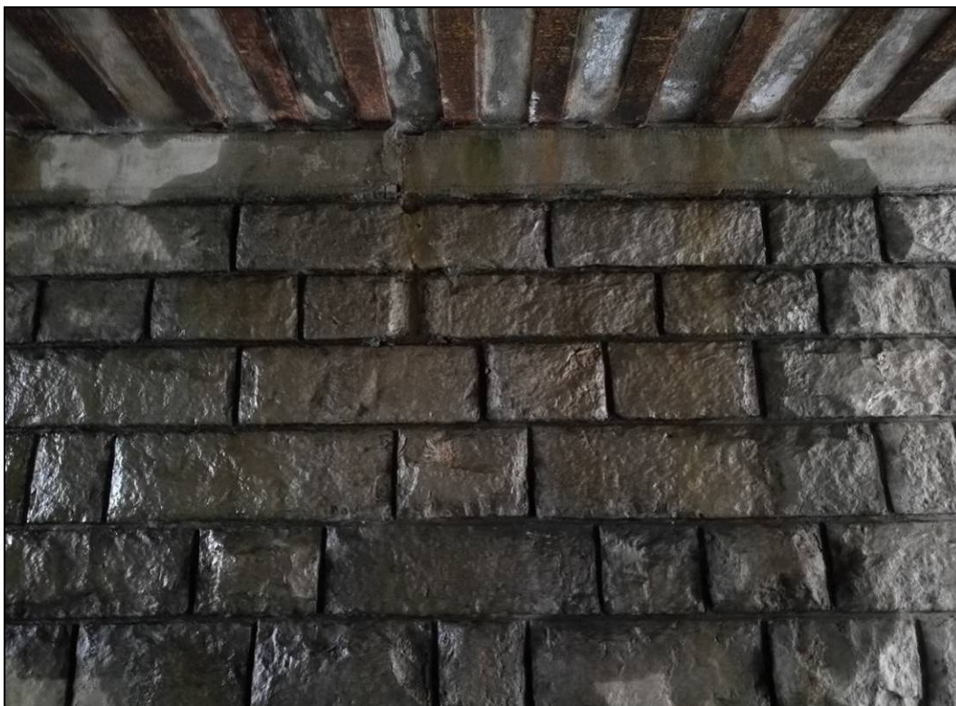
Obr. č. 6 - pohled na opěru - v líci a na styku NK a SS s průsaky vody
